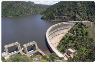
General view of Mulargia reservoir in Sardinia. Source: Ente acque della Sardegna (ENAS)
