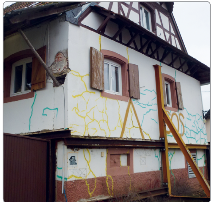
Maisons endommagées par les mouvements de terrain dans le village de Lochwiller (Alsace, France)
