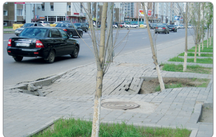
Subsidenza nell'area urbana indotta da una perdita nella rete idrica. Credito: meadowsaffron su flickr
